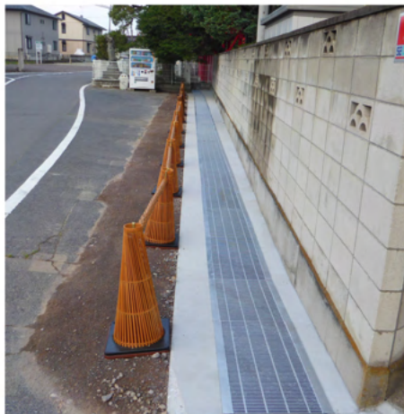
▲工事後の様子。この面に新たに掲示板を設置します。
