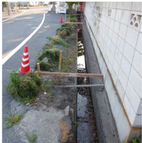
▲施工前の様子。景観が悪く、安全面でも心配がありました。
